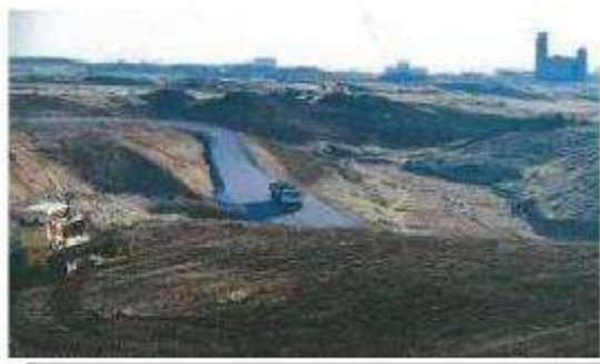
二期工事着手 (1986年)
