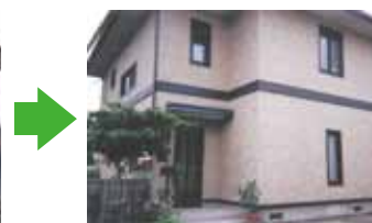
住宅防音工事実施後 （防音ドア、防音サッシなど交換）
