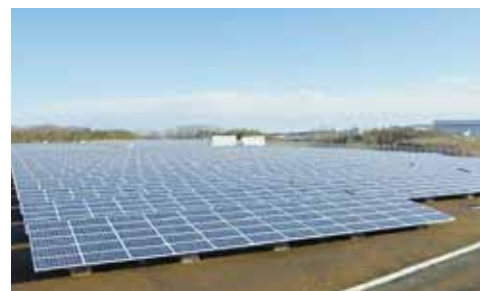
三里塚太陽光発電所
