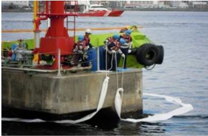
【吸着マットによる漏洩油回収】
