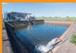
③ 雨水処理施設
