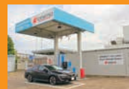
⑥ 水素ステーション
