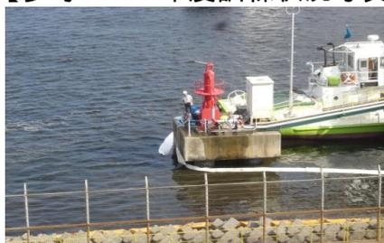
【吸着マットによる漏洩油回収】
