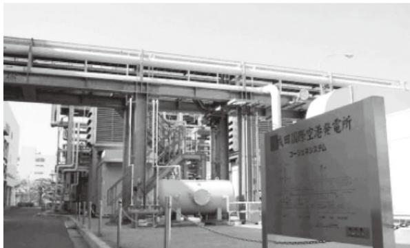
中央受配電所は成田空港の電力施設の大きな特徴であり、電力会社から6万6000Vで一括受電している。この一括受電方式は個別受電による受電設備や予備電源などの重複を避け、設備効率や運転効率を高める利点がある。
