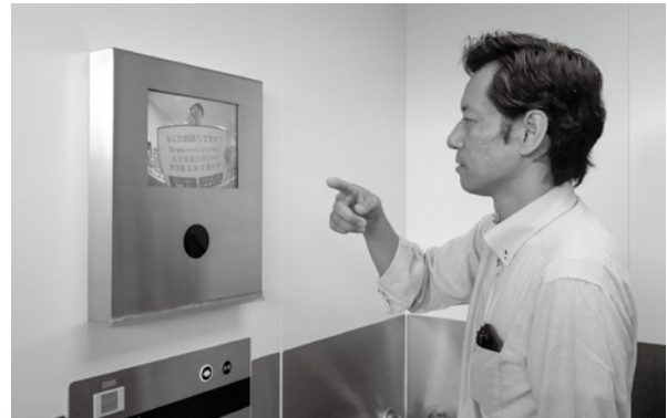
エレベーター内部にはテレビ電話のモニターとカメラも
