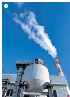
①EGDが管理する施設のひとつ、ヒーティングプラント。空港の各施設に温水を供給する、成田空港で言えば中央冷暖房所にあたる施設だが、石炭を熱源としているのが日本の施設にはない特徴。②夕暮れ時の誘導路。ウランバートル市街から約50km離れているため、空港周辺は平原が広がり、遠くには雪山が見渡せる。
