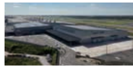
太陽光発電システムを導入する第8貨物ビル
