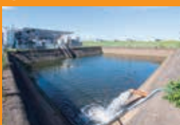
③ 雨水処理施設
