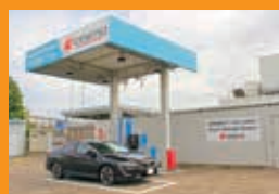
⑥ 水素ステーション
